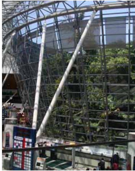
Kuala Lumpur 機場中庭的雨林造景。
